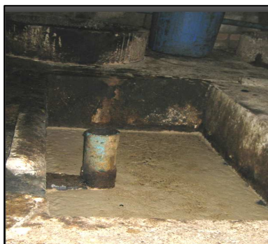
ภาพที่ 2-2 บ่อดักไขมัน , เจ้าหน้าที่ดูแลระบบบำบัดน้ำเสียและดักไขมันออกจากบ่อดักไขมันและถุงดำบรรจุไขมัน
