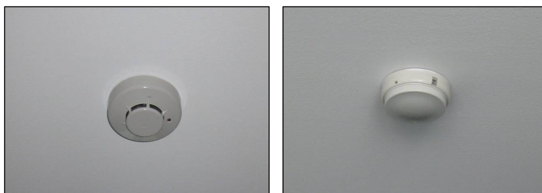
ภาพที่ 1-9 อุปกรณ์ตรวจจับความร้อนและอุปกรณ์ตรวจจับควัน
