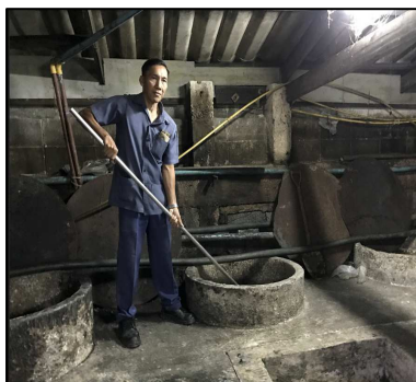
ภาพที่ 2-2 บ่อดักไขมัน , เจ้าหน้าที่ดูแลระบบบำบัดน้ำเสียและดักไขมันออกจากบ่อดักไขมันและถุงดำบรรจุไขมัน
