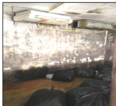
ภาพที่ 2-2 บ่อดักไขมัน , เจ้าหน้าที่ดูแลระบบบำบัดน้ำเสียและดักไขมันออกจากบ่อดักไขมันและถุงดำบรรจุไขมัน
